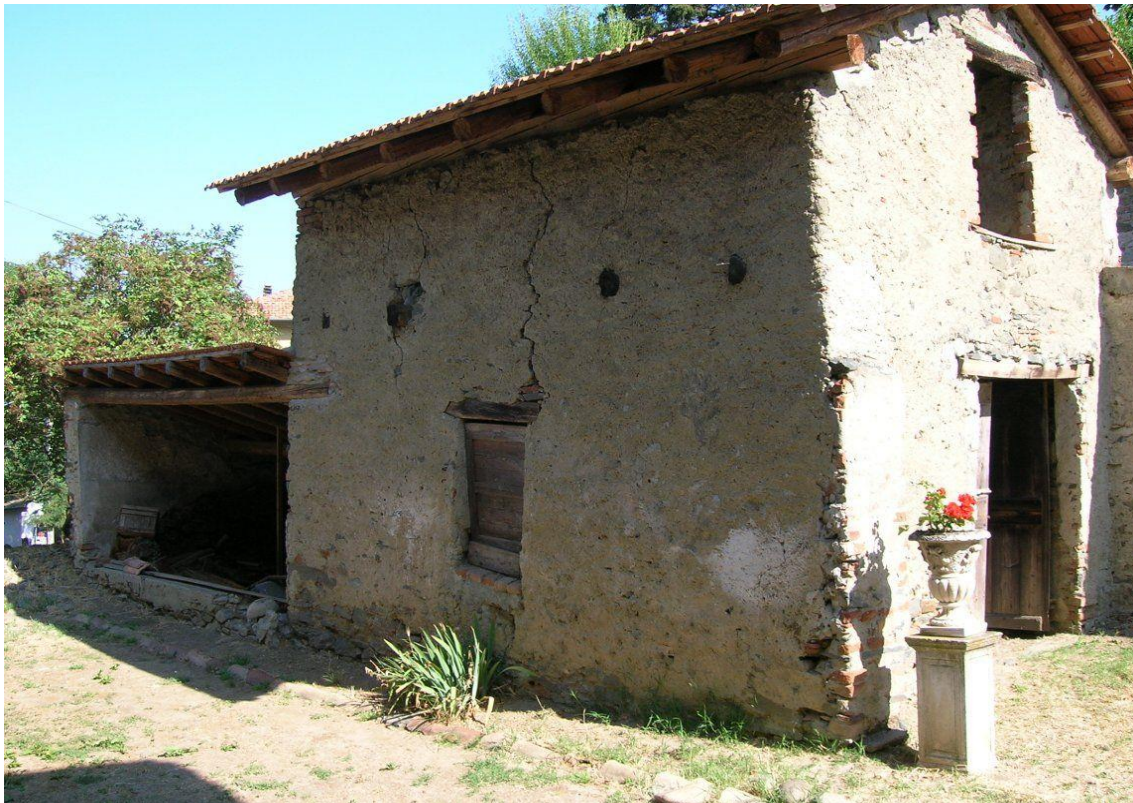
Schuur (voormalige kastanjerokerij) en houtopslag
